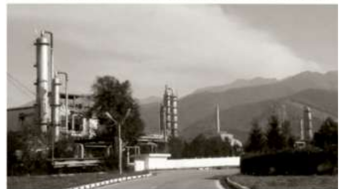
Die Säulen der Methanol- Herstellungs Anlagen
